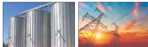
Tanques de almacenamiento peligrosos
