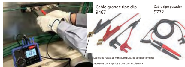
Medición de baja resistencia Prueba de continuidad después de la medición de la resistencia de tierra
